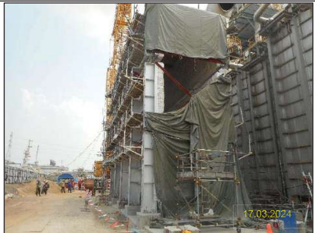
ค) กิจกรรมการติดตั้งหน่วยหมุนเวียนพลังความร้อนเหลือทิ้งกลับคืน (Waste Heat Recovery Unit: WHRU)
