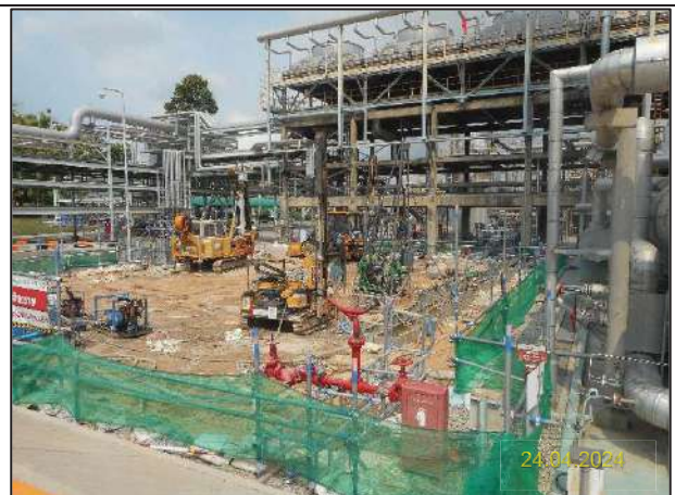
ง) กิจกรรมการติดตั้งหอแยกก๊าซโพรเพน (New DePropanizer Column) และระบบหล่อเย็นแบบ Air Cool
